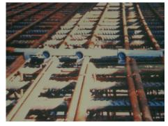
Comodidad de colocación de la armadura en encofrados: además de distanciar uniformemente el hierro, lo fija para su posterior atadura.
