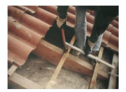
Muy útil en la colocación rápida y totalmente paralela de rasteles de madera en cubiertas.
