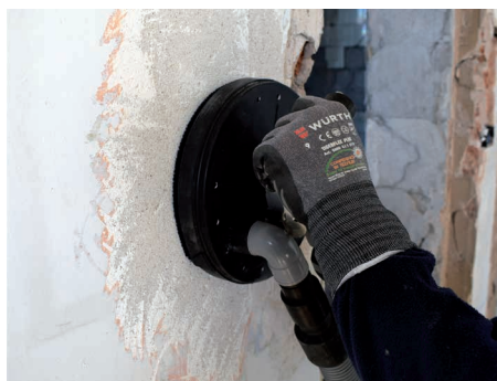
Quitar mortero con disco diamantado PCD
